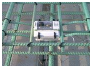
شکل ۱۴- سنسور ECL در حین عملیات [۱۷]
