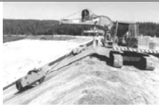
شکل (۴): تسطیح بستر پوشش محافظ و طریقه نصب لایه ژئوتکستایل بر روی بستر آماده شده در محل
