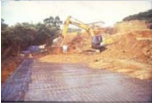
شکل (۴): تسطیح بستر پوشش محافظ و طریقه نصب لایه ژئوتکستایل بر روی بستر آماده شده در محل
